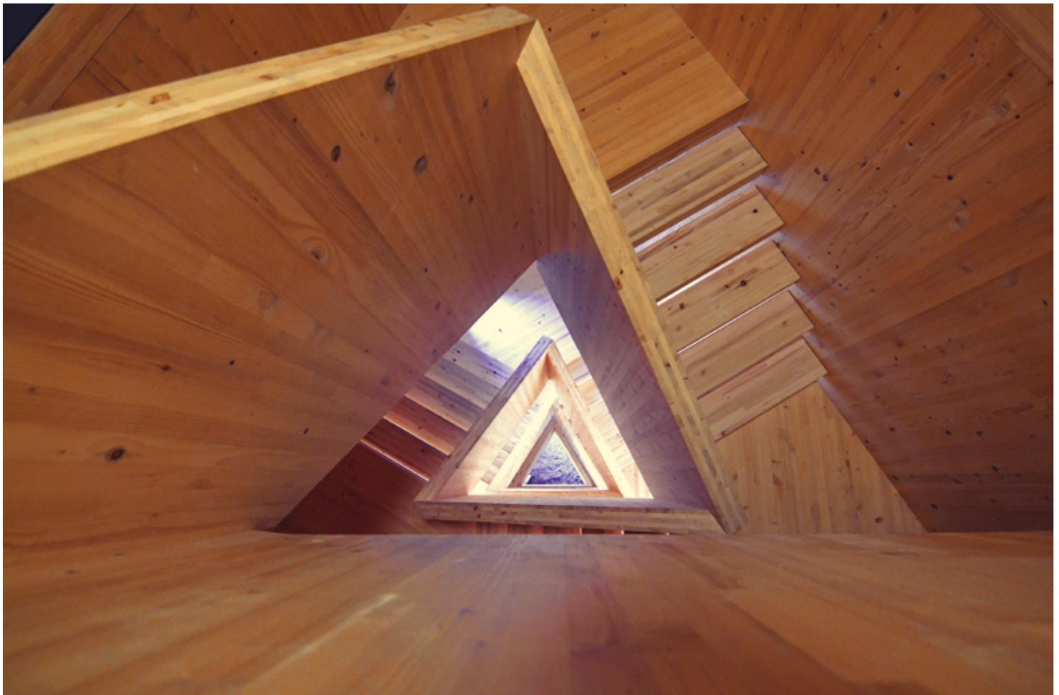
Das gesamte Treppenhaus besteht aus sichtbaren Weisstanne-Platten. Insgesamt wurden über 100m<sup>3</sup> Brettschichtholz und Brettsperrholz eingesetzt.
