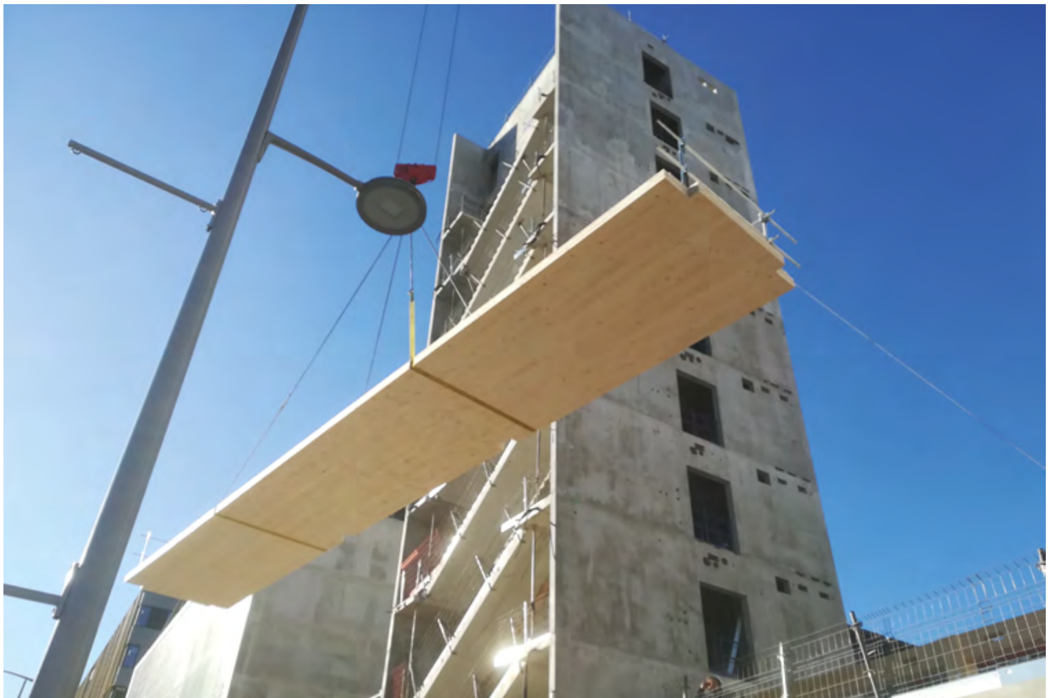
Dank Bodenelementen von einer Länge von 16,9m konnte die Aufrichtezeit des 35m hohen Gebäudes sehr kurz gehalten werden.
