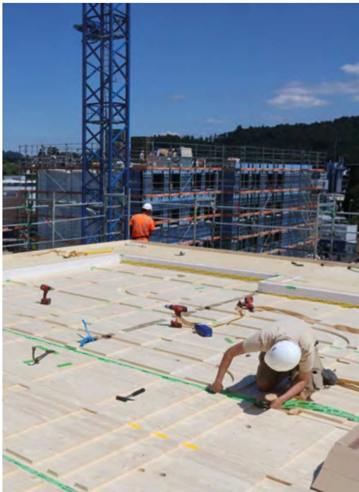
Für die vier Häuser durfte Schilliger Holz AG über 5600 m 2 Massivholz-Bodenplatten erstellen und abbinden.
