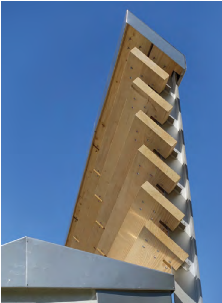
Six types de lames composent les systèmes anti-éblouissement.
