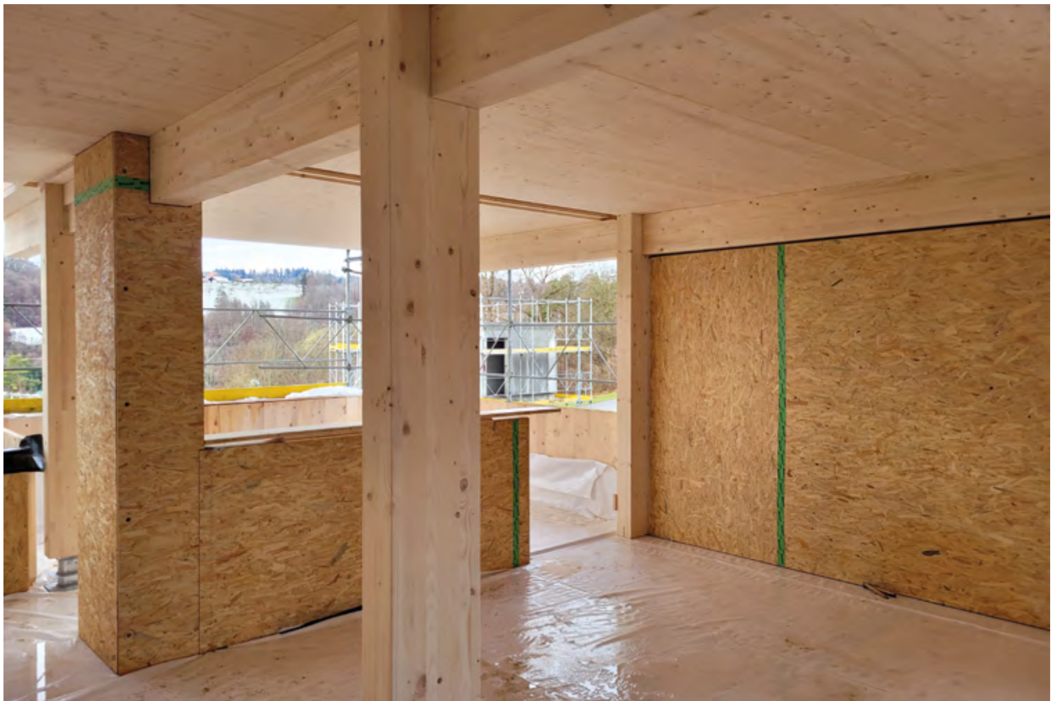
Für die 12 Häuser durfte Schilliger Holz AG über 1000 Massivholz-Bodenplatten erstellen und abbinden.
