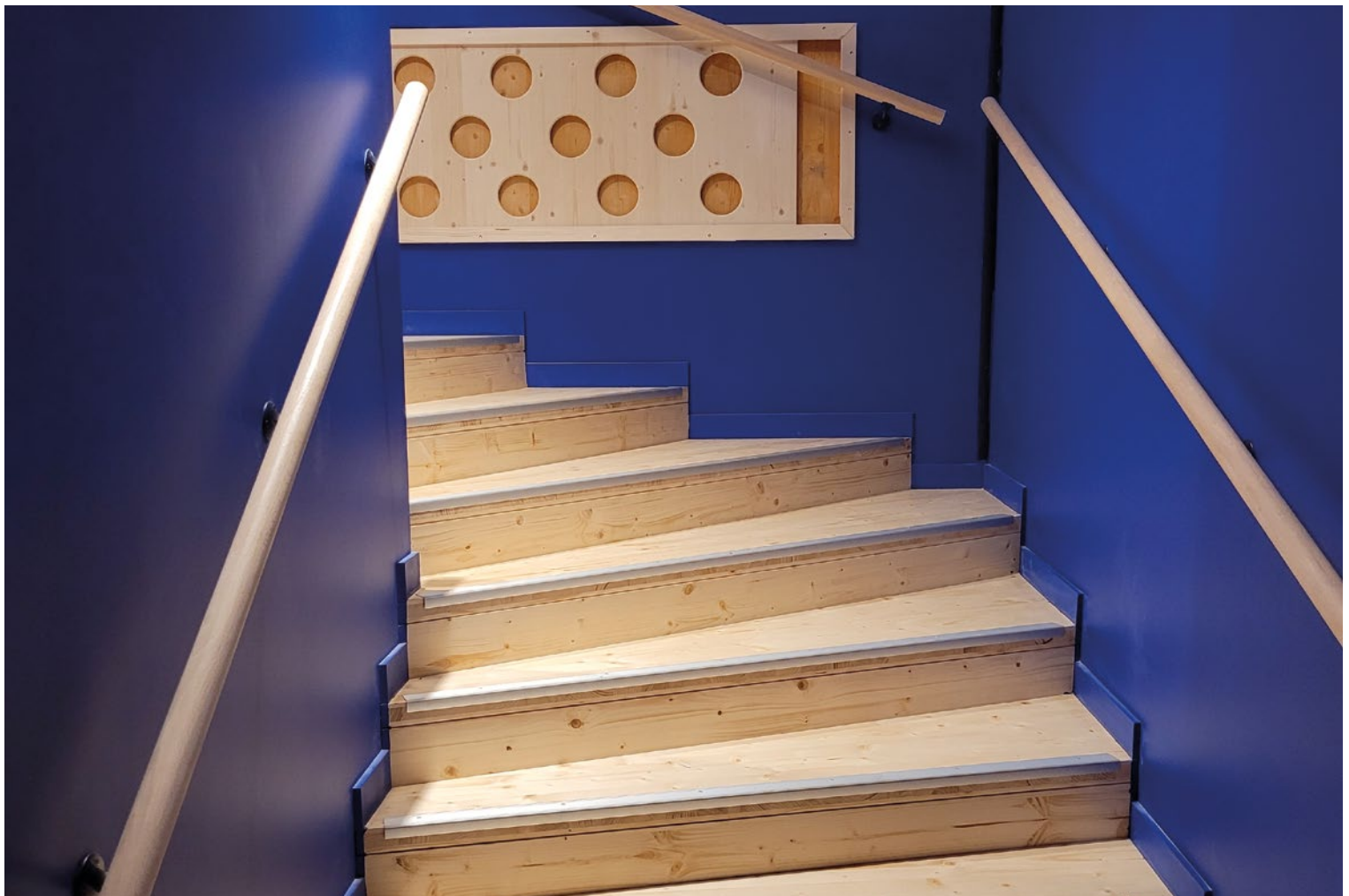
Die 200m 3 CLT und Leimholz, die von Schilliger Bois geliefert wurden, sind im Innern fast durchgehend sichtbar.
