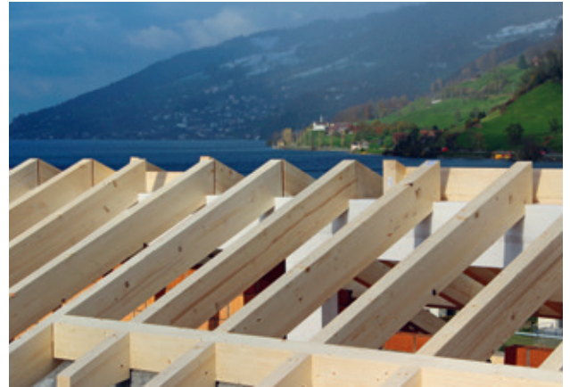
Dachstock Mehrfamilienhaus, Arth
