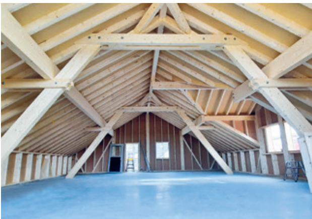
Dachstuhl Garagengebäude, Rothenburg LU
