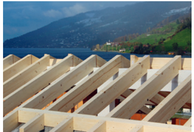
Dachstock Mehrfamilienhaus, Arth
