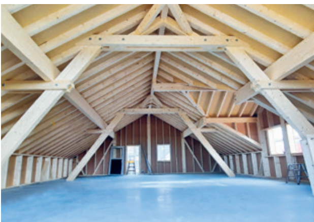
Dachstuhl Garagengebäude, Rothenburg LU
