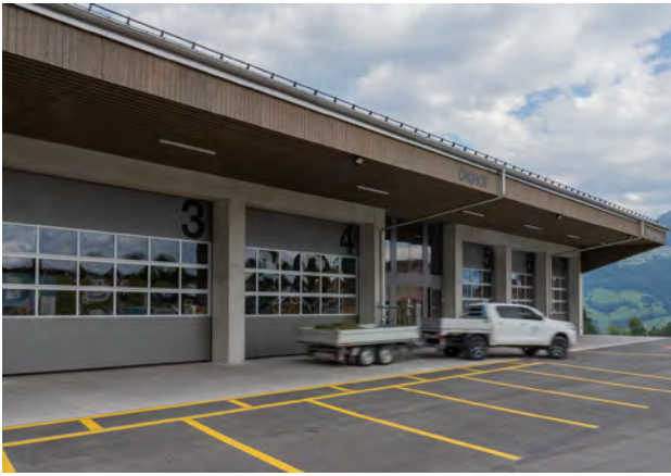
Centro Servizi, Udligenswil
