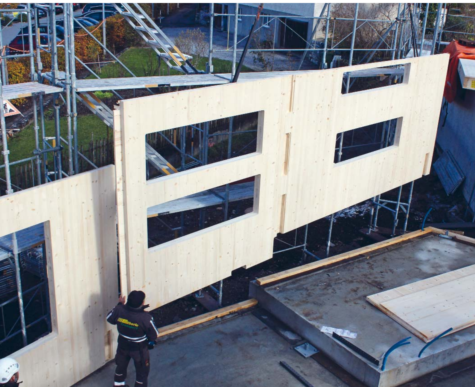
Giunto pannelli impalcati
